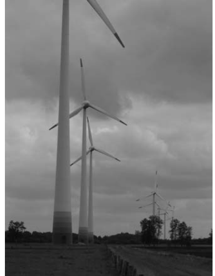
Het windpark (12 E-66's) te Borsum vlak bij de grens met Groningen
