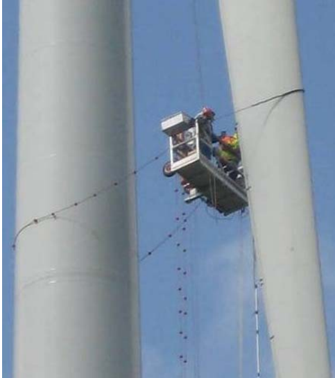
Onderhoud aan een rotorblad van de Amstelvogel
